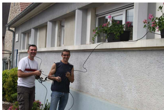
Remise à neuf de l'installation d'arrosage automatique
