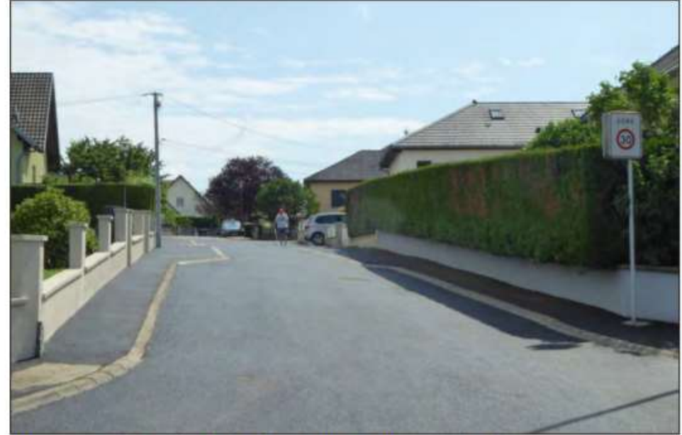
Un nouveau tapis d'enrobés a été posé dans la rue Saint-Gangolphe à Galfingue. Photo L'Alsace/A.L.
